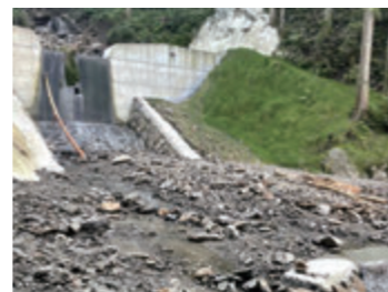
治山ダムは一気に埋まりオーバーフローした瓦礫が散乱
