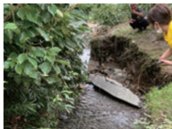
柿畑のコンクリート擁壁を壊し侵食を拡大する谷
